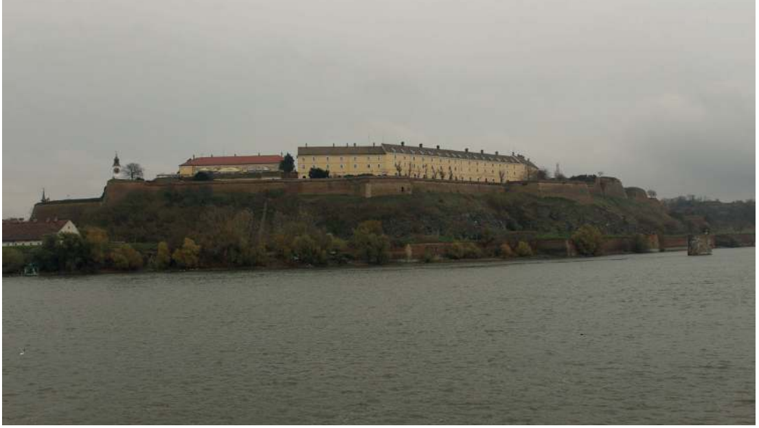
Fotoğraf 122 1: Tuna'nın Sol Kıyısında Novi Sad'dan Varadin Kalesinin Görünüşü.
